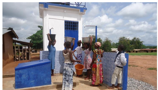
Beim AG-Besuch noch Baustelle, jetzt in Betrieb: Die mechanisierte Pumpe in Mintakrom.
