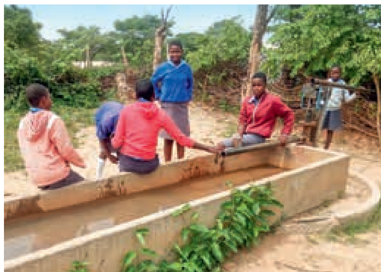
Plan International und Viva con Agua fördern in Simbabwe den Bau von Wasserentnahmestellen sowie Maßnahmen für eine bessere Hygiene.
